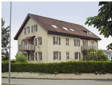
Schulhaus mit Baujahr 1857 im Oberdorf. Heute als Mehrfamilienhaus genutzt.
