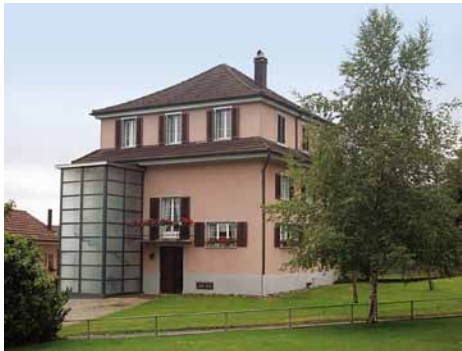
Das erste Schulhaus der Gemeinde, erstellt 1812. Heute Wohnhaus im Mitteldorf.
